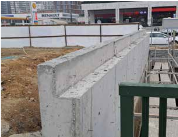
Betonarme Perde Yapım Çalışması
