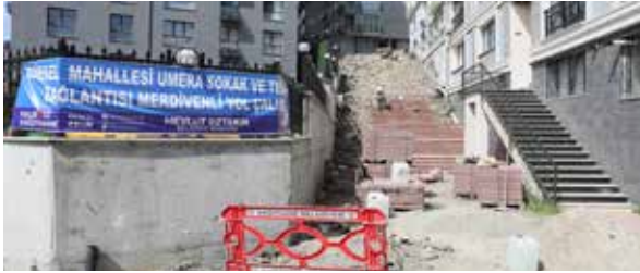
Merdiven ve Yol Yapım Çalışmaları
