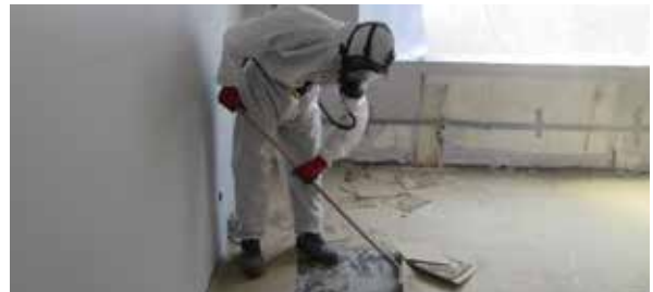
Asbest Söküm Çalışmaları
