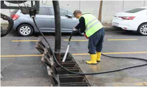
Yağmursuyu Kanalı Temizleme Çalışması
